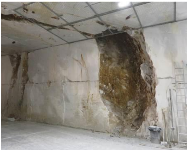
Discontinuità all'interno di una galleria.
